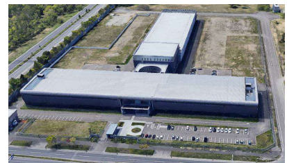
石狩データセンター
